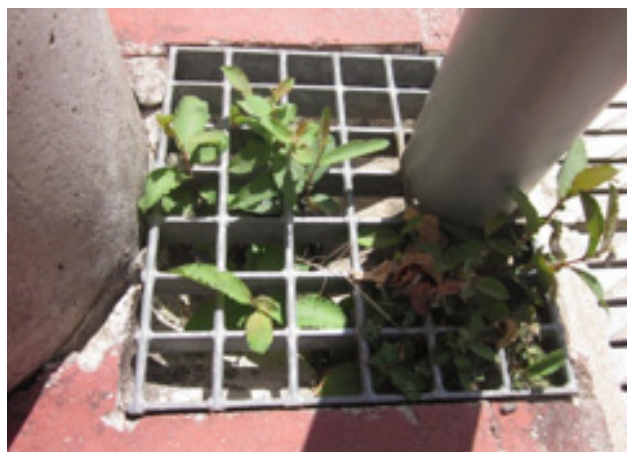
Imagen 1. Rejilla de desagüe del patio del centro.
